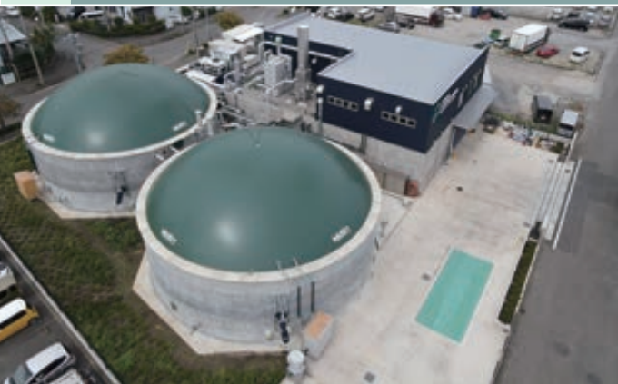
生ごみから年間1000戸分の電力を作り出す／さがみはらバイオガスパワー
